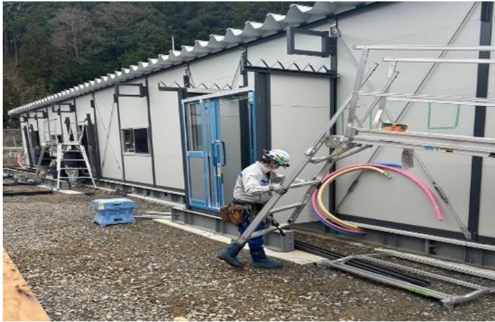
仮設住宅建設現場の様子
