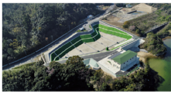
一般廃棄物最終処分場 浸出水処理施設
