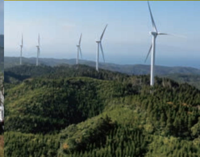
串間風力発電所
