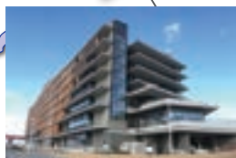
長崎県庁舎 行政棟 (電気)
