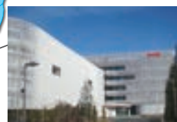
明治八王子新研究所 (空調管)
