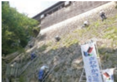
行橋諏訪神社石垣清掃（北九州）
