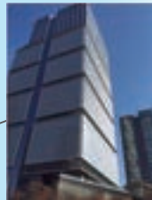
東京ガーデンテラス紀尾井町（電気）
