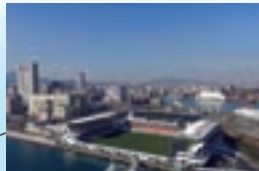
北九州スタジアム（電気／空調管）
