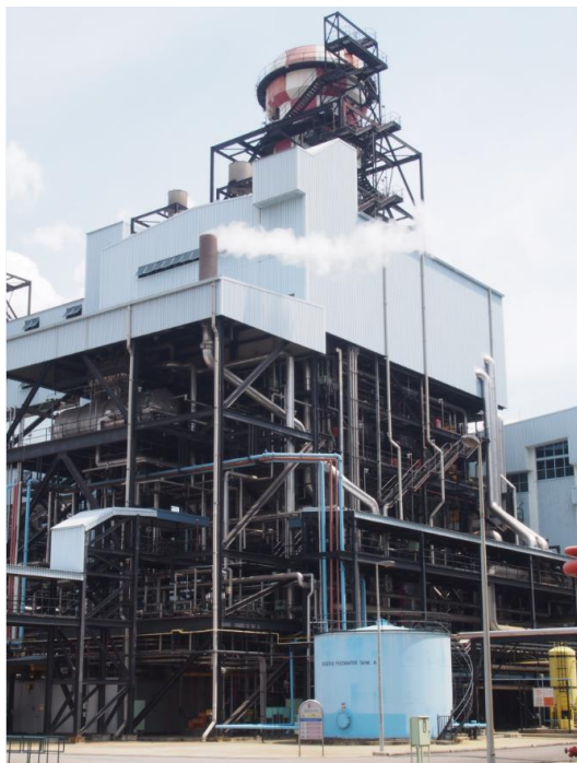
施工事例(シンガポール) TUAS発電所
