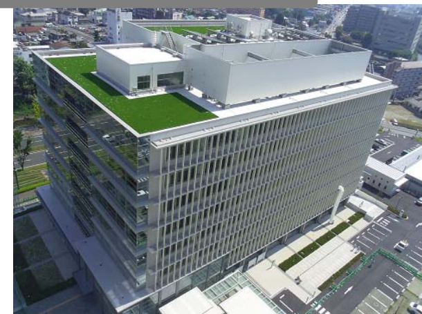
熊本合同庁舎建設・マネジメント（PFI事業）
