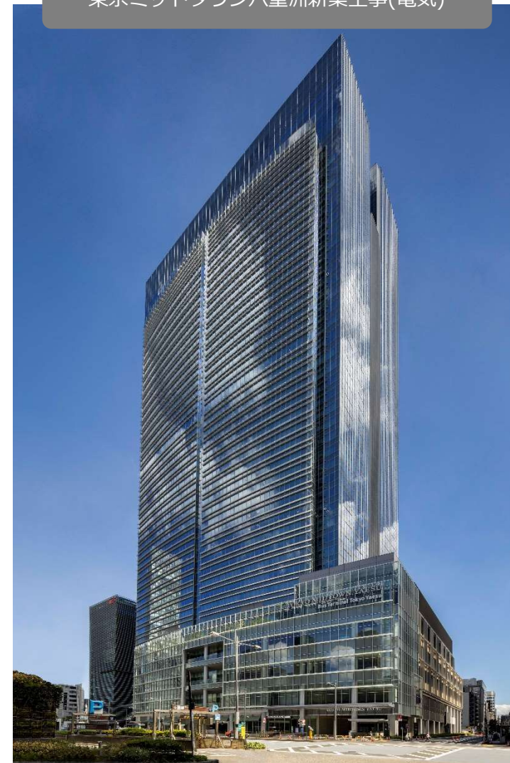
東京ミッドタウン八重洲新築工事(電気)
