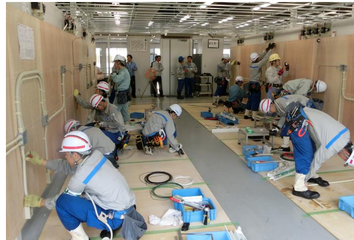
電気配線研修
