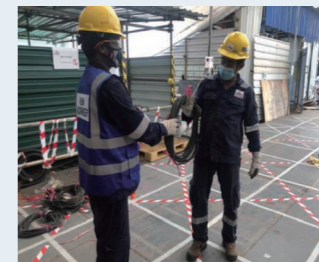
新しい技能工に寄り添う先輩技能工
