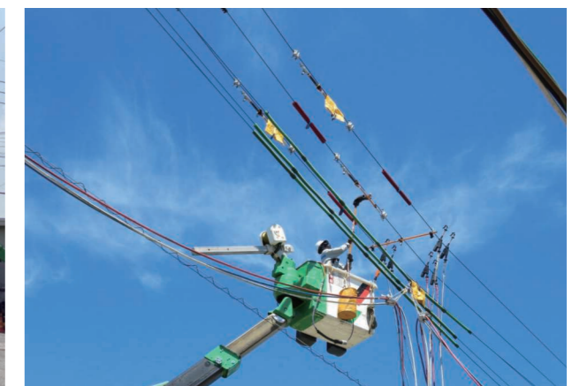
間接活線工法
