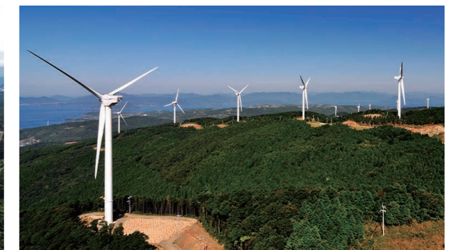
串間風力発電所
