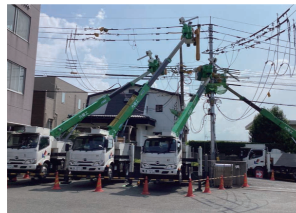
配電委託工事
