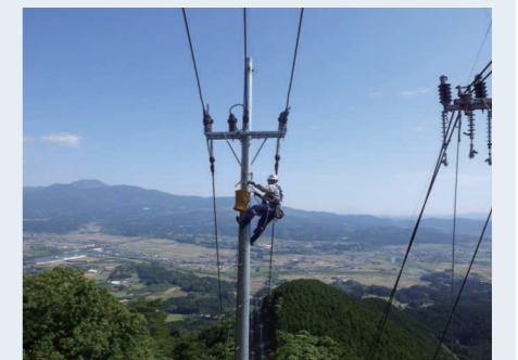
再生可能エネルギー連系自営線工事
