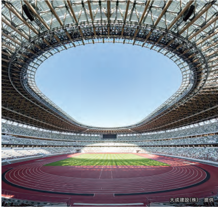
国立競技場 大成建設(株) 提供 電気
