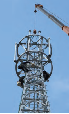
携帯電話基地局建設
