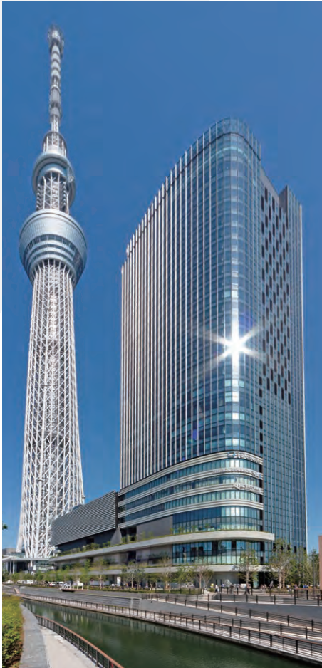
東京スカイツリータウン® 電気 空調管
