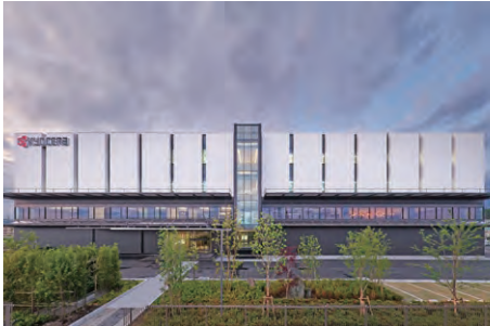
京セラ株式会社 きりしまR&Dセンター 撮影：楠瀬友将 空調管
