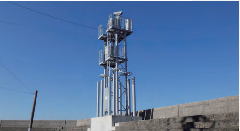
大分港海岸みなとカメラ設置工事他 情報通信
