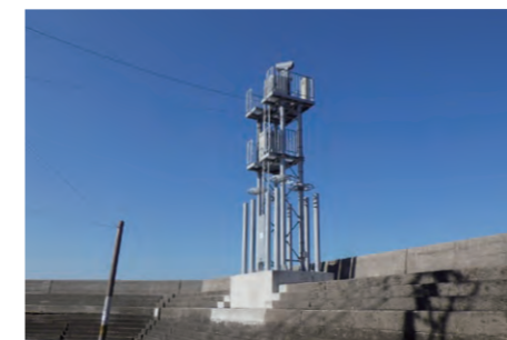
大分港海岸 みなとカメラ設置工事他
