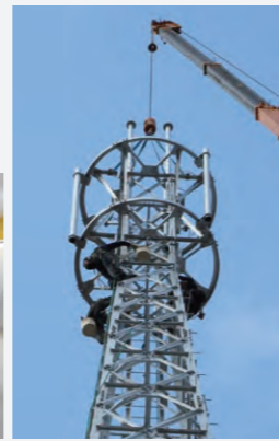
携帯電話基地局建設
