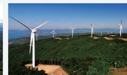
串間風力発電所
